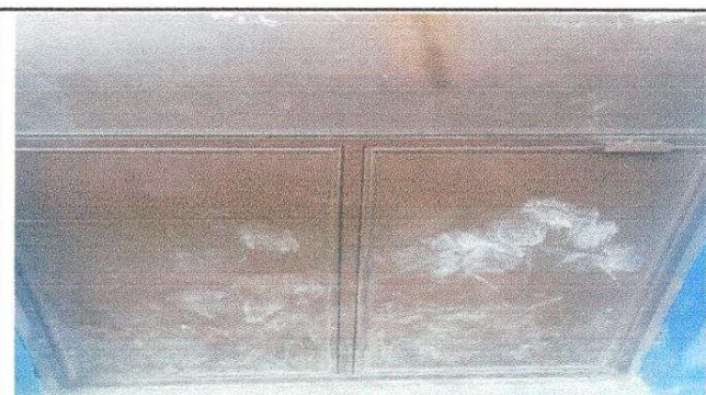
Foto 3: Mantenimiento a estructura de puertas de metal
