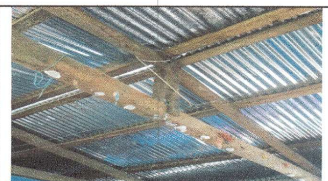
Foto 6: Cableado eléctrico en mal estado
