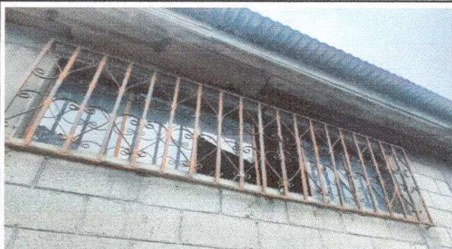
Foto 1: Mantenimiento de ventanas, balcones y vidrio
