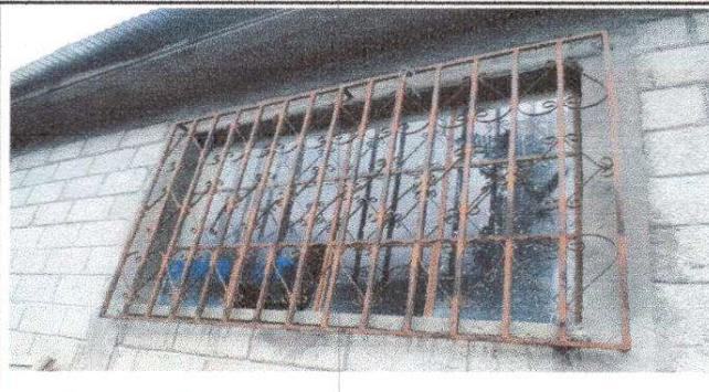
Foto 2: Mantenimiento de ventanas, balcones y vidrio
